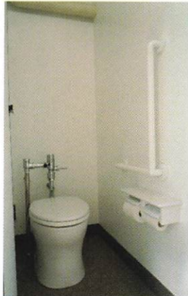
手すりのついたトイレ
